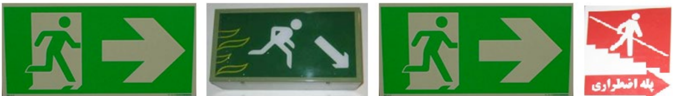
شکل ۵- انواع علائم نامناسب (الف) انواع برچسبی موجود در لاله‌زار به نام شبرنگ (ب) انواع برچسبی بر روی پلیت پلاستیکی (ج) انواع قدیمی و برقی ضعیف (د) انواع خارجی که مورد تأیید مقررات ملی ساختمان و آتش‌نشانی نیستند.
